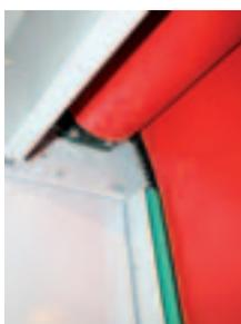
**3** La bombatura viene intercettata dal raggio delle fotocellule che, in abbinamento al sistema elettronico DSC, bloccano ed invertono la discesa del telo riavvolgendolo totalmente.
